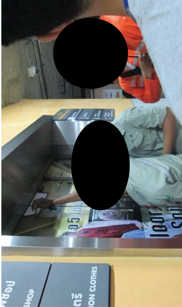
ฝ่ายวิศวกรรม - ทีมช่างไปที่จุดเกิดเหตุ และไขเบรกลิฟต์เพื่อตรวจสอบว่าลิฟต์จอดตรงชั้นหรือไม่
